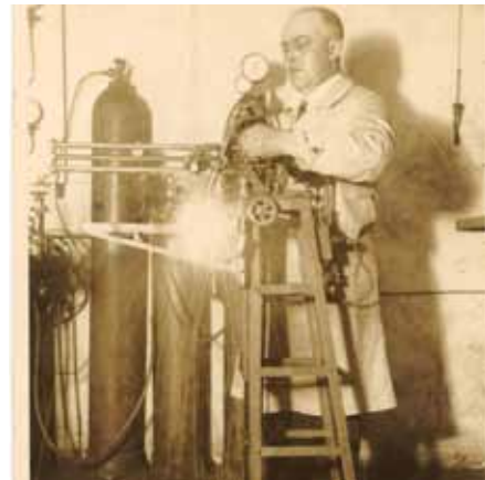
1932 Hans Greggersen bei der Entwicklung der ersten Greggersen-Brennschneidmaschine.
